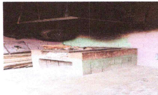
Foto 4: Mejoramiento de cocina con instalación de estufa con ladrillo y chimenea.
