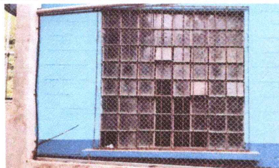
Foto 3: Sustitución de ventana área de cocina a ventana corrediza para servir alimentación escolar.
