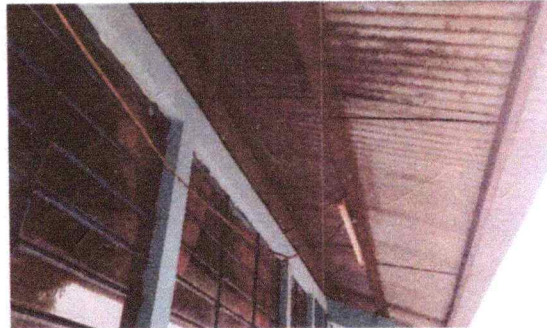
Foto 8: Sustitución de sistema eléctrico en área del corredor y las aulas pendientes de instalación de energía.
