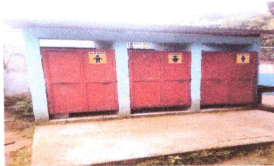
Foto 10: Sustitución de puerta en áreas de baños
