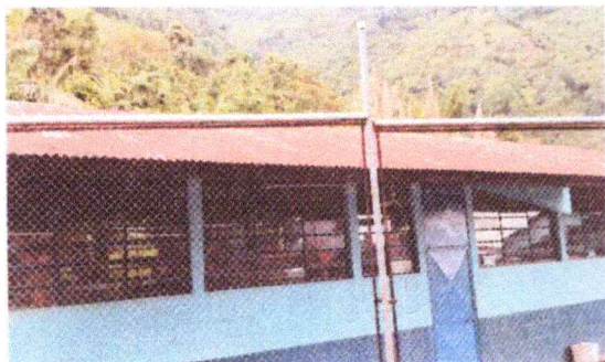
Foto 1: Mejoramiento de techo con láminas troqueladas.
