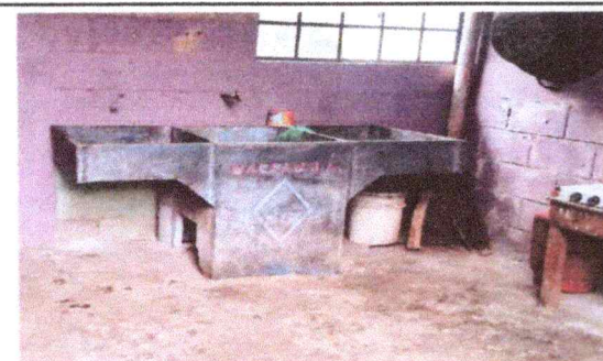
Foto 5: Sustitución lavatrastos por una fabricada en obra azulejado.
