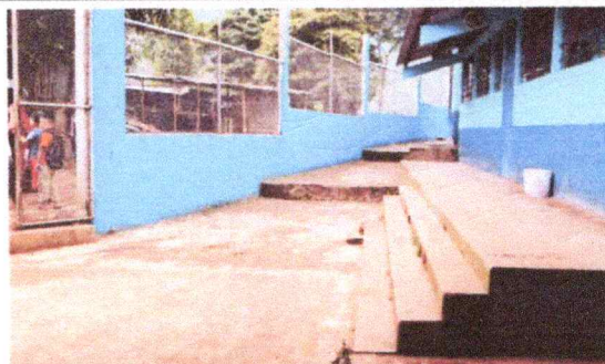
Foto 2: Mejoramiento de piso de concreto del corredor de la escuela y colocacion de caja y tubería de registro de bajada pluvial
